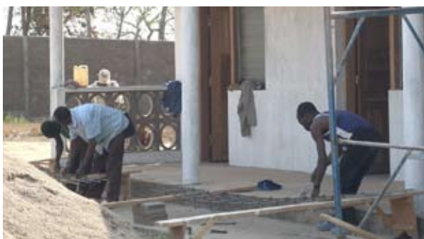
il cantiere del Centro di Coordinamento del Trattamento per i malati di Aids della missione di Bouar
